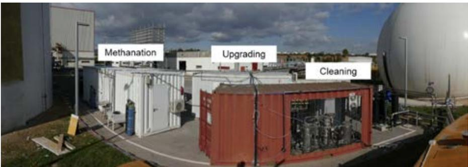
**Figura 2.** Imagen de la planta piloto de metanación implementada en una estación depuradora de aguas residuales
